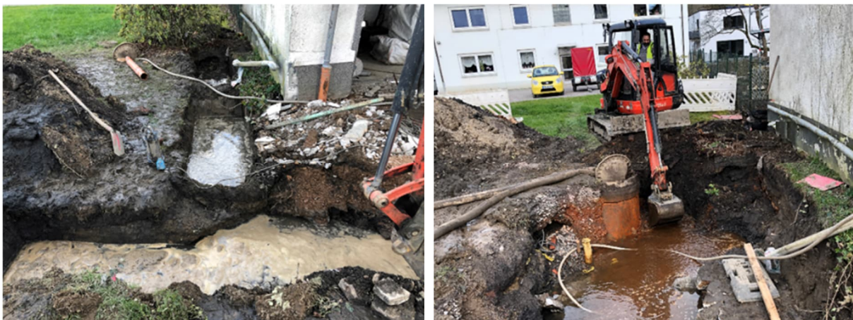
Abbildung 5: Wasserstand zu Beginn der Untersuchung (links) sowie erweiterter Schurf 1 mit freigelegtem Drainageschacht und Wasserzufluss (rechts)
