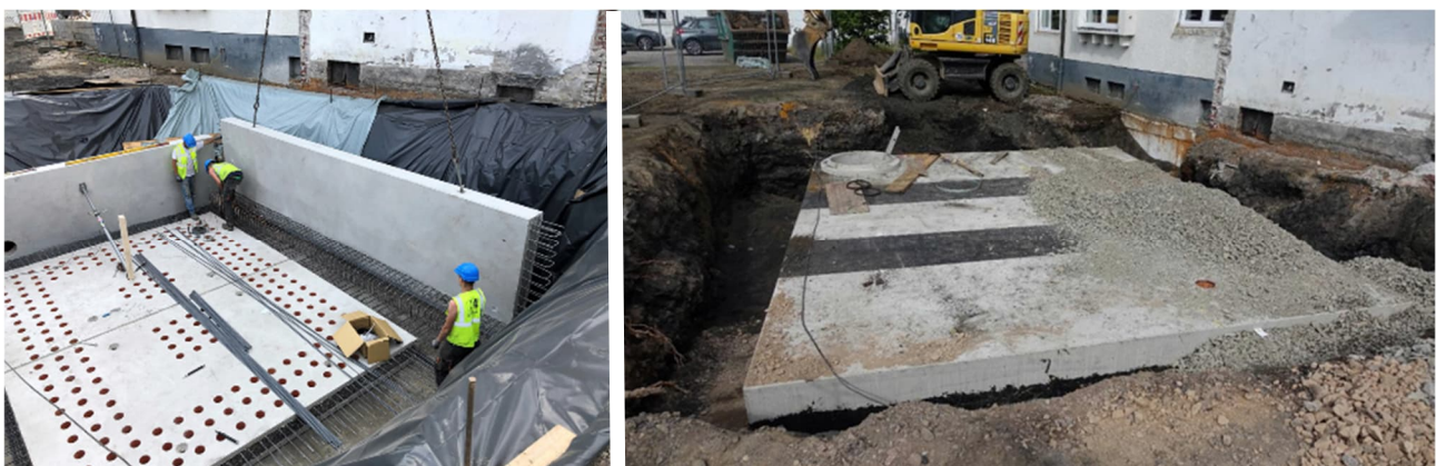
Abbildung 16: Montage der Fertigteile (links) und fertiggestelltes Bauwerk (rechts)
